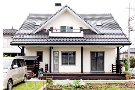
北洲ハウジングの特色のひとつである大屋根と、アルセコの塗り壁がコントラストを成している。雨が当たると壁はセルフクリーニングできる仕様。
