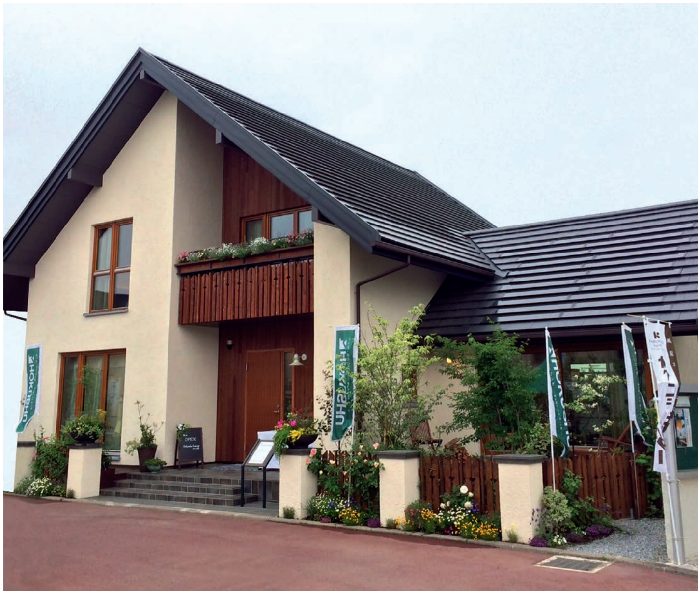
北洲らしい大屋根デザイン。断熱性に優れたアルセコの外壁と木の質感がベストマッチ。
