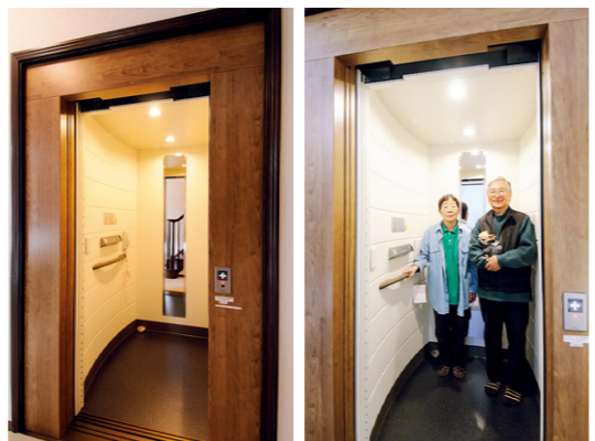
木彫デザインの扉の中には、丸くカーブした白い壁の空間。車いす用の鏡、手すり、空調など、十分な設備機能を備えています。
