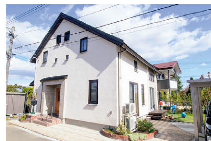
④アルセコ外断熱システム、瓦一体型の太陽光パネルなど、機能性とデザイン性を一挙に満たす提案を盛り込んだNさま邸外観。
