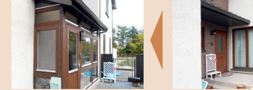
既存の玄関屋根を解体せず、継ぎ足して活用。その継ぎ足し部分が隠れるように、天井に羽目板を張りました。また元の玄関の色合いにあわせ、同系色のタイルや木材を採用しました。
