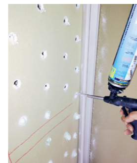
戸建と異なり、構造に大きく手を入れることのできないマンション。特性に合わせて最適な断熱工事を行うことがポイントです。
