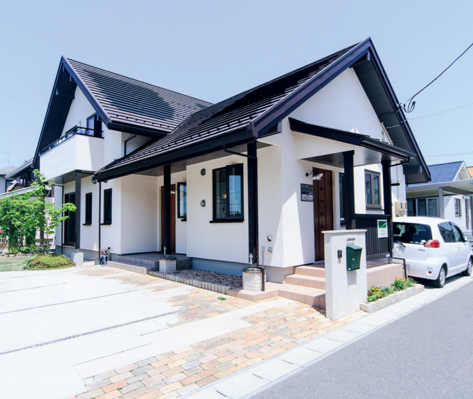
②住居部分と店舗が自然にマッチした外観。ソーラーパネルは、屋根のデザインに馴染む瓦一体型を採用。
