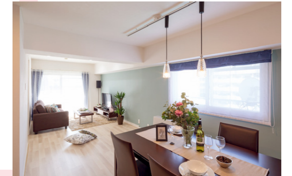
工場であらかじめカットした材料で施工するので近隣の騒音を極力抑え、工期も短縮。このモデルルームは、20日間で完工。
