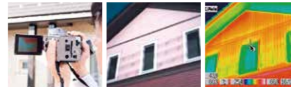
サーモグラフィカメラによる測定
