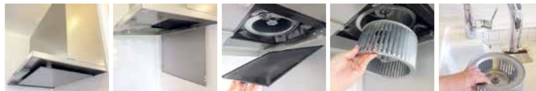
レンジフード本体 1.レンジフードカバー 2.レンジフードフィルター 3.シロッコファン 4.水洗い
