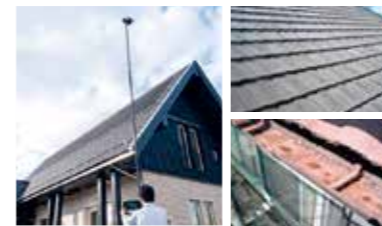
ポールカメラによる測定
