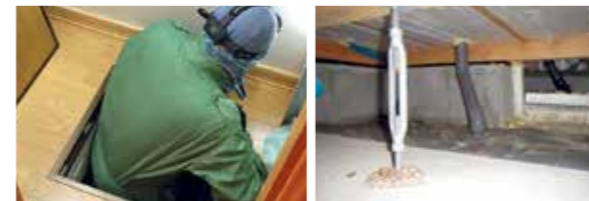
床下点検の様子
