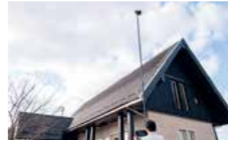
高所ポールカメラ / 小さな釘の浮きや屋根材のスレを発見し原因特定につなげます。
