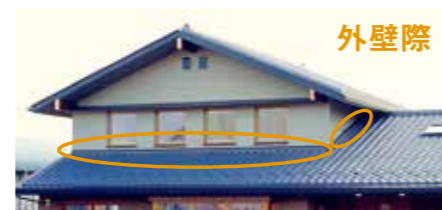
高所ポールカメラ / 小さな釘の浮きや屋根材のスレを発見し原因特定につなげます。
