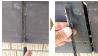
▲古く固くなったシーリングを剥がし、新しい充填材を注入するスキマを作ります。
