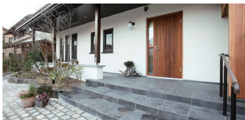
玄関 ポーチの大きな屋根が雨や日差しをさえぎります。 自転車も入れる広さです。
